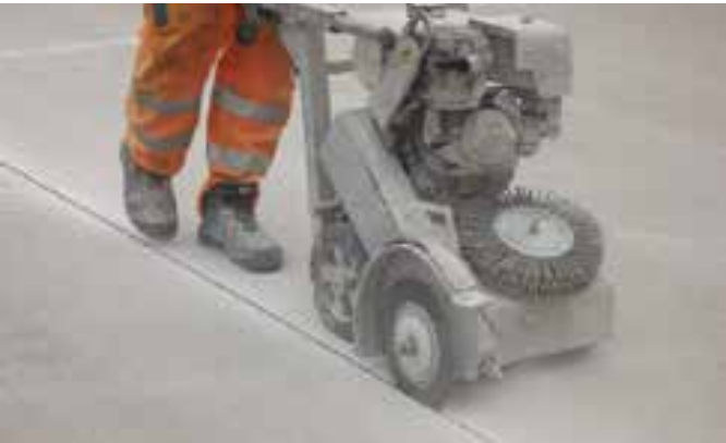
Fugenbürste im Straßenbau im Einsatz.
